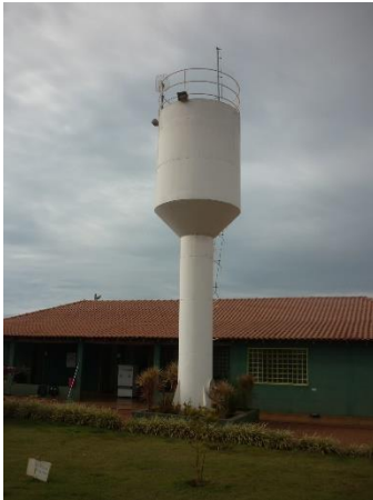
Reservatório para armazenamento da água captada no poço tubular profundo CRTR Ambiental Sul
