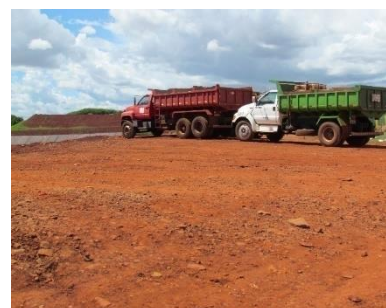
Figura 43. Caminhão basculante no aterro CRTR Ambiental Sul Doré Engenharia, 22/01/2014
