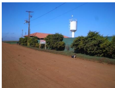
Figura 24. Prédio administrativo e reservatório de água potável CRTR Ambiental Sul Doré Engenharia, 09/05/2014
