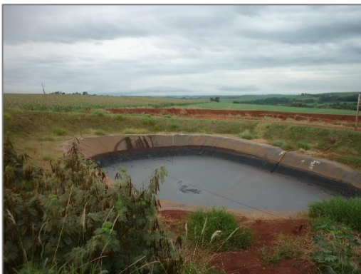
Vista da lagoa de armazenamento de chorume com sistema de impermeabilização de base CRTR Ambiental Sul
