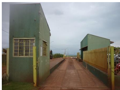
Figura 22. Guarita e balança CRTR Ambiental Sul Doré Engenharia, 15/06/2015
