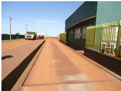
Balança e estrutura para pesagem e controle de recebimento de resíduos sólidos CRTR Ambiental Sul
