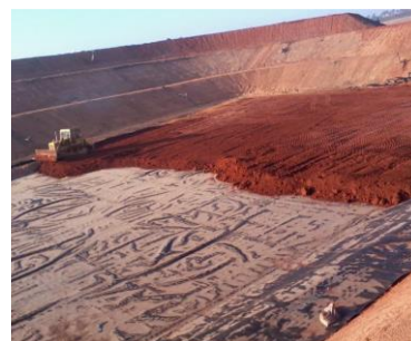
Figura 32. Aplicação da camada de solo de proteção mecânica Fonte: Destra (2014)
