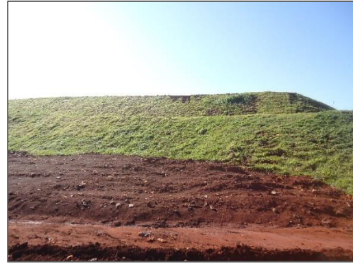
Constituição de taludes CRTR Ambiental Sul
