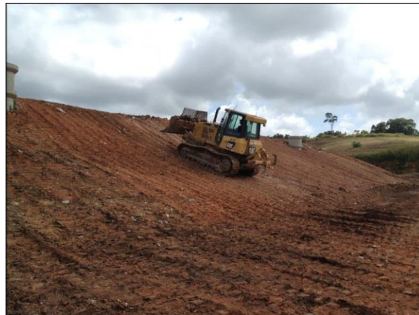
Figura 29. Execução da cobertura dos resíduos ao término da jornada de trabalho Fonte: Destra (2014)
