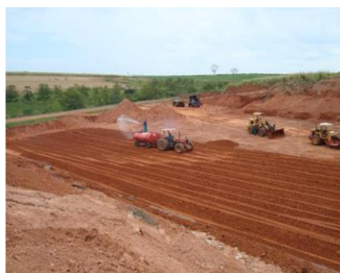
Figura 30. Procedimento de compactação do solo de base Fonte: Destra (2014)
