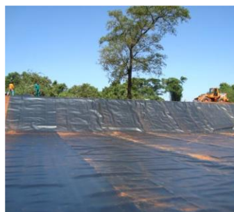
Figura 31. Aplicação da geomembrana de PEAD sobre o solo compactado Fonte: Destra (2014)
