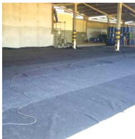
Figura 20. Modelo de manta geotêxtil para proteção de geomembrana de PEAD
