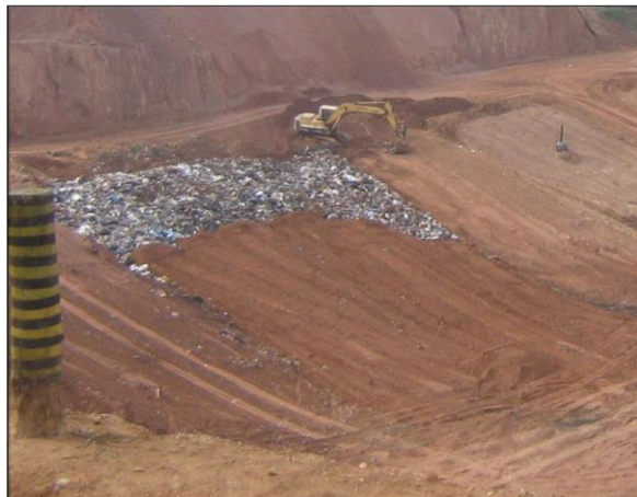
Figura 28. Execução da cobertura dos resíduos ao término da jornada de trabalho Fonte: Destra (2014)
