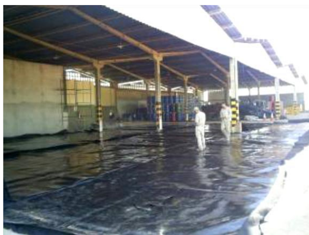
Figura 19. Modelo de aplicação da geomembrana de PEAD
