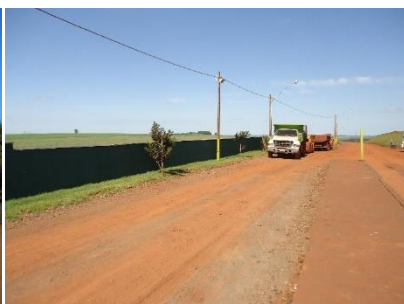
Figura 25. Muro de alvenaria e sistema de distribuição de energia elétrica CRTR Ambiental Sul Doré Engenharia, 27/03/2014
