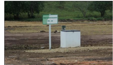
Figura 12. Poço de monitoramento
