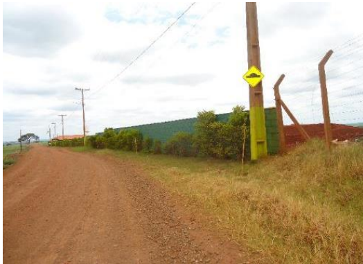
Via de acesso a CRTR Ambiental Sul e identificação de sinalização vertical
