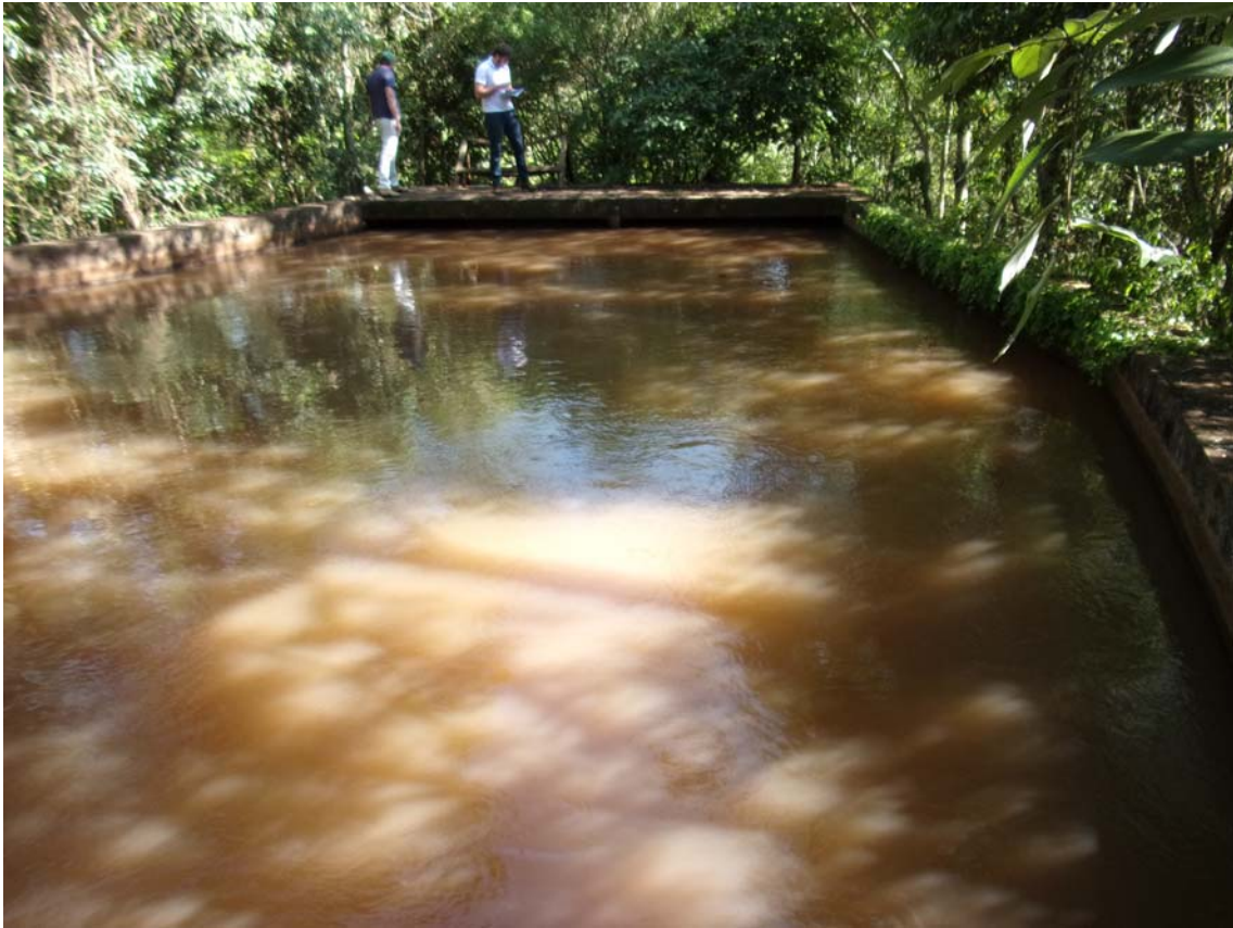
Figura 17 - Câmara de carga seguida pela tomada d'água de alta pressão. Fonte: CS Ambiental, 2014.
