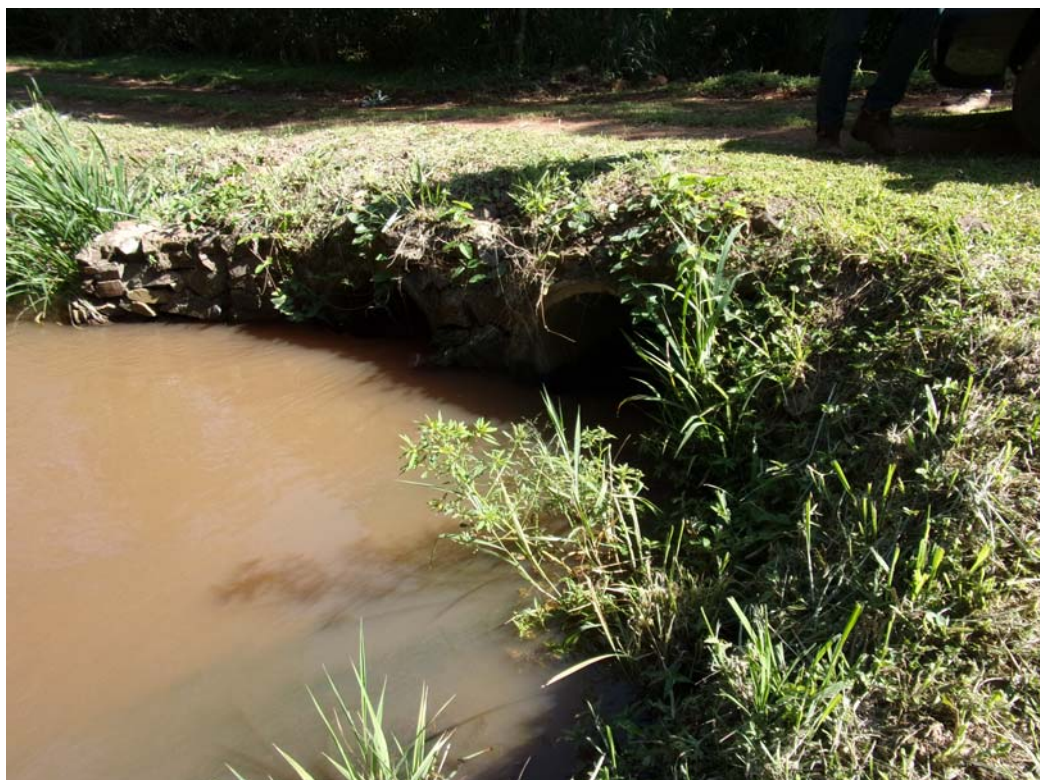
Figura 22 – Canal de Fuga. Fonte: CS Ambiental, 2014.
