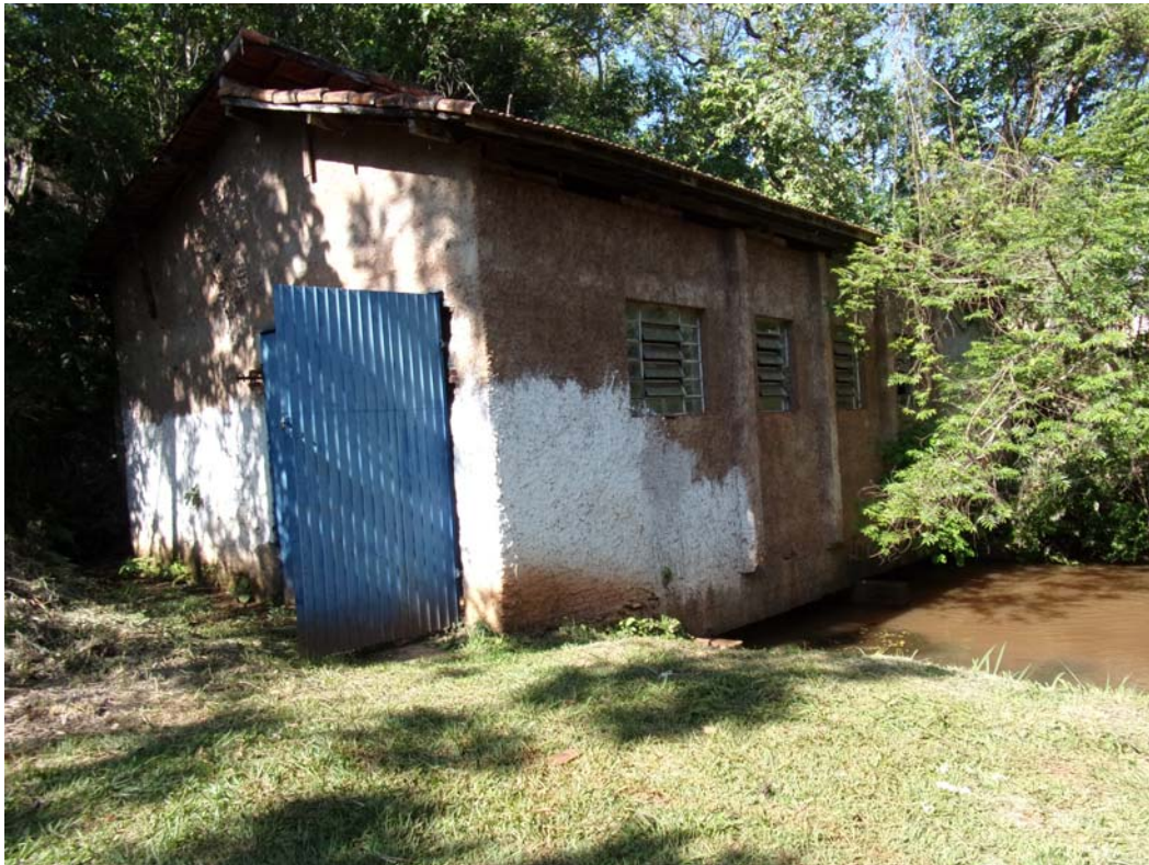
Figura 20 – Casa de Força Fonte: CS Ambiental, 2014.
