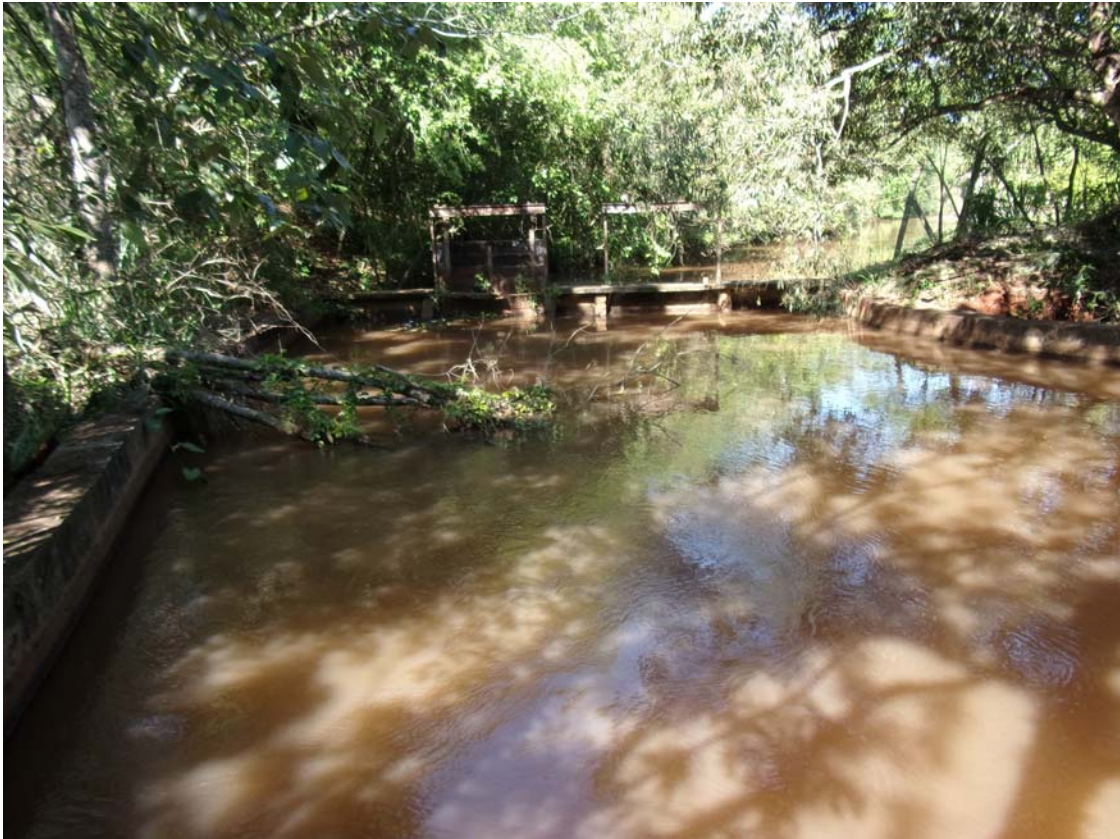
Figura 16 – Comportas da câmara de carga. Fonte: CS Ambiental, 2014.
