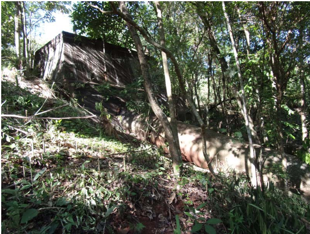
Figura 19 - Conduto forçado e Câmara de Carga. Fonte: CS Ambiental, 2014.
