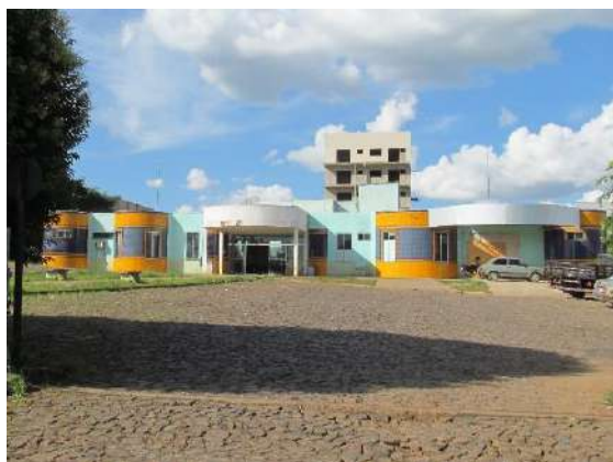
Figura 8.4: Hospital municipal de Pinhão-PR. Fonte: Construnível, 2015.
