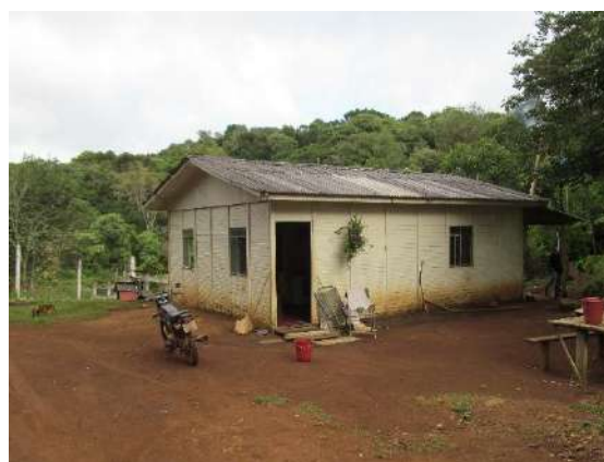
Figura 8.11: Moradia local. Fonte: Construnível, 2015
