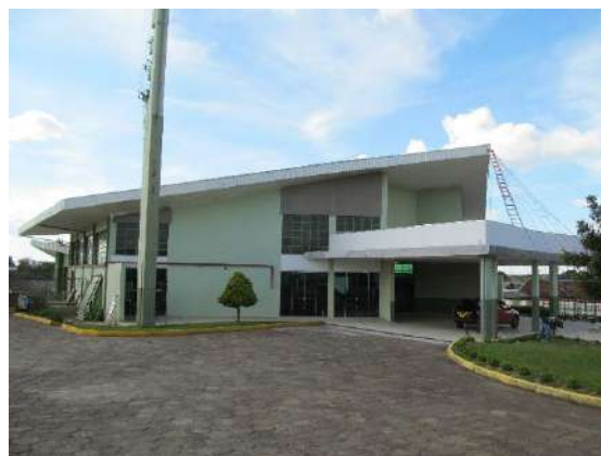
Figura 8.5: Pronto atendimento. Fonte: Construnível, 2015.
